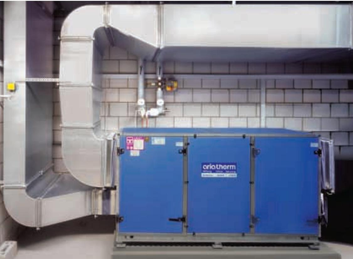
Monobloc zur Wärmerückgewinnung aus Abluft und Nachheizung der Frischluft aus dem Erdregister
