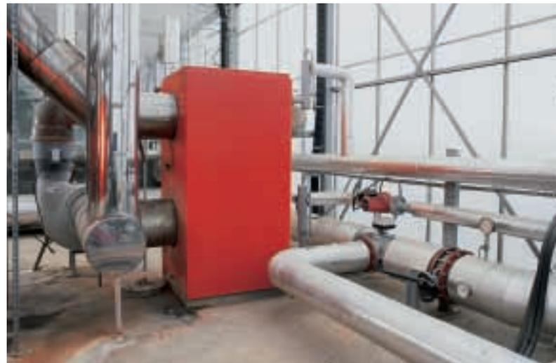
Kondensations-Rekuperator im Abgasweg des mit Erdgas befeuerten Kessels
