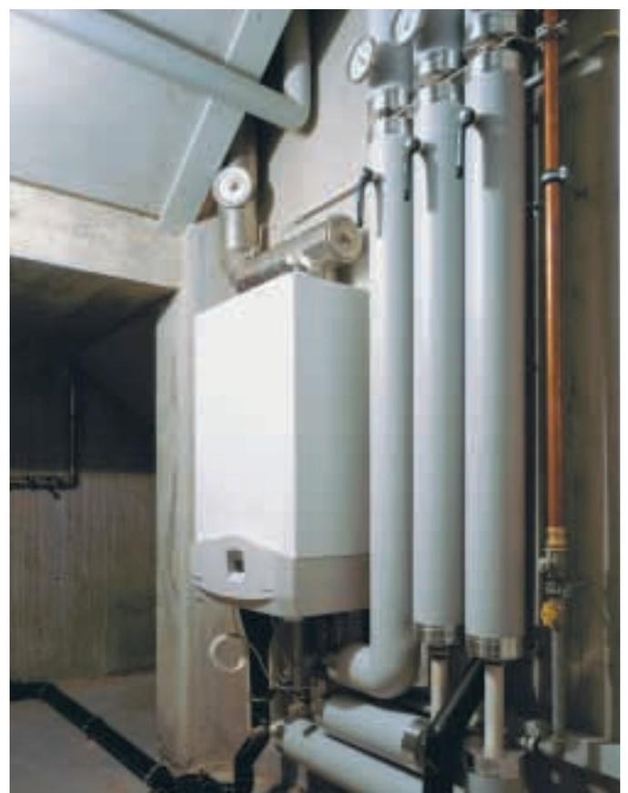
Platzsparend unter dem Treppenhaus: Gas-Kondensationskessel mit Modulation von 8 – 28 kW
