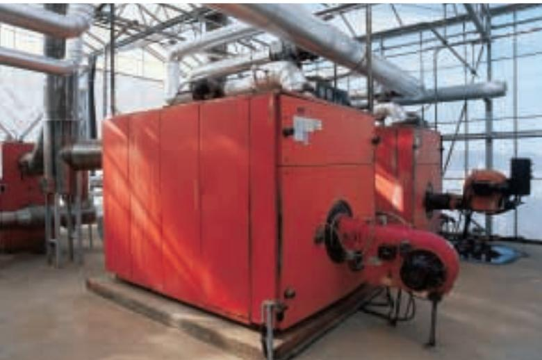
Vorne der 1500 kW-Heizkessel mit Gas-Gebläseburner, hinten der kleinere Reservekessel
