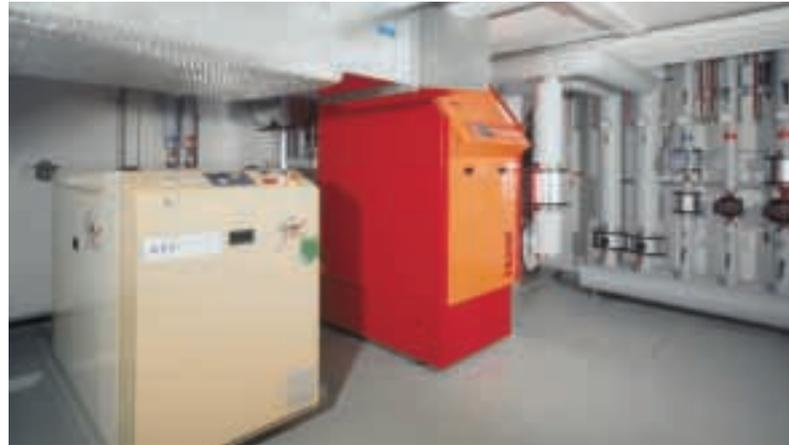
Hinten der von 44 – 250 kW modulierende Gas-Kondensationskessel, vorn das BHKW mit 19,6 kW<sub>e</sub> und 40 kW<sub>th</sub>
