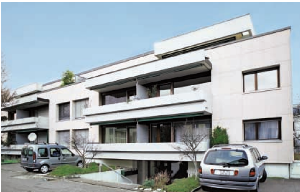
Im Zehnfamilienhaus in Reinach BL erzeugt eine WKK-Pionier-Anlage Wärme und Strom
